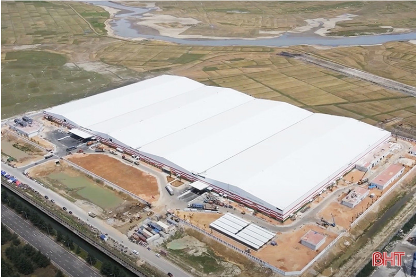
Nhà máy sản xuất pin VinES tại Khu kinh tế Vũng Áng, Hà Tĩnh. Nguồn ảnh: Báo Hà Tĩnh.
