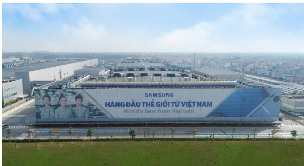
Nhà máy của Tập đoàn Samsung, Hàn Quốc, đặt tại tỉnh Bắc Ninh, Việt Nam. Nguồn ảnh: Vietnam Investment Review.
