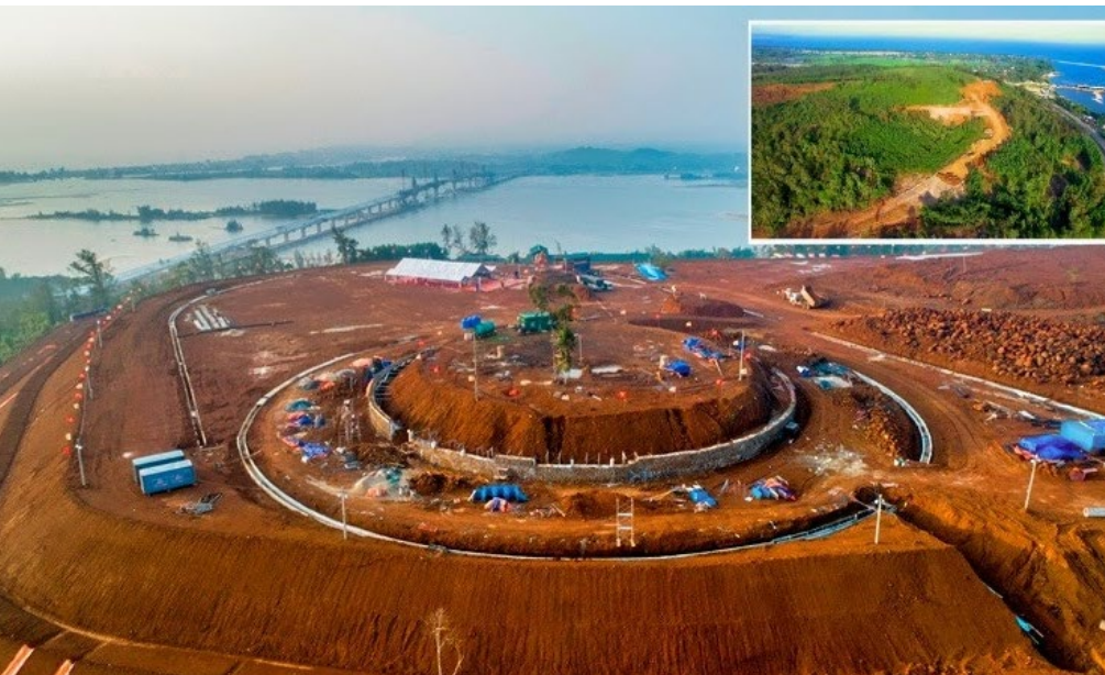
Khu vực thi công chùa Minh Đức tại núi Thiên Mã, tỉnh Quảng Ngãi vào tháng 9/2019 (ảnh lớn) và khu vực này lúc mới thi công (ảnh nhỏ).
